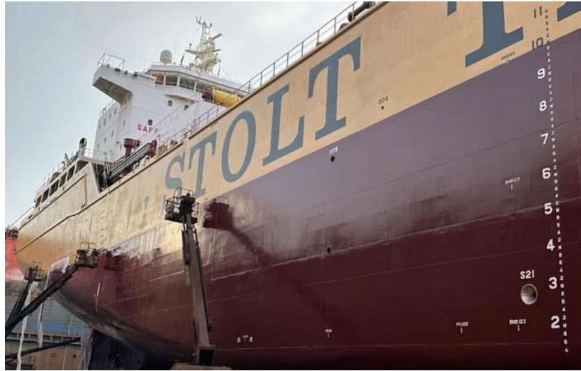
Figure 2 : Revêtement de la coque d'un des navires Stolt [17]
