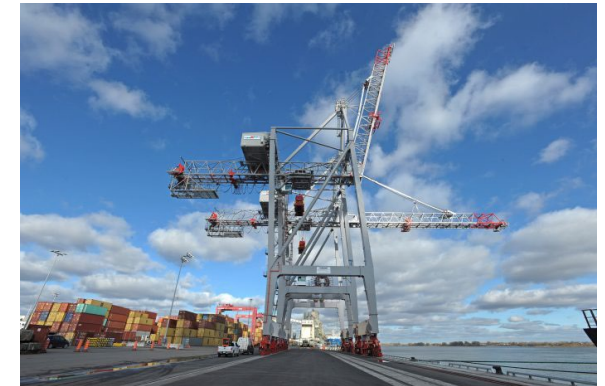
Électrification des navires de service et des grues portiques de plusieurs terminaux du Port de Montréal
